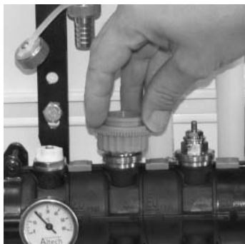
Skru den medfølgende plastadapter på ventiltoppen
