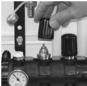
Afmonter det nederste håndgreb
