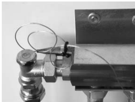
Føleren anbringes mellem blanderør og ophængsbeslag.
