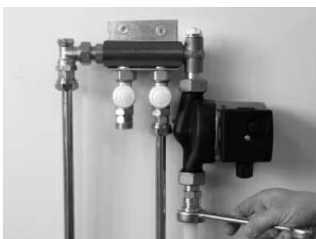
Tilslut frem gulvvarme.
