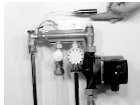
Kapillarrørsføleren placeres i rummet, hvor temperaturen ønskes reguleret
