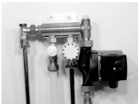
Alternativt kan shunten forsynes med en termostat med rumføler i stedet for blandeventil pos. 2.
