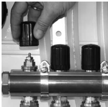
Afmonter det nederste håndgreb
